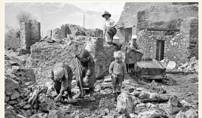
Vom Dorfzentrum von Arbaz bleiben nach einem Brand im Juli 1924 nur rauchende Trümmer. zvg
